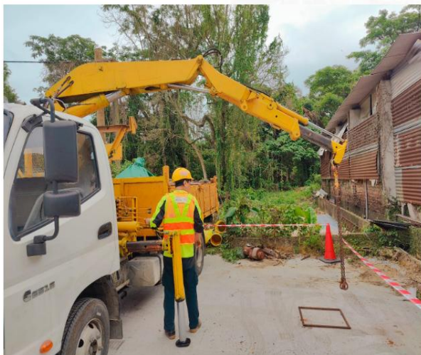
伸出腳撐及支架進行吊運
